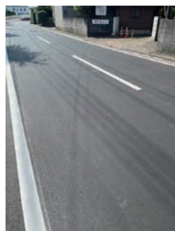
舗装の修繕が終わった道路
